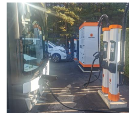
Ladepark Schlatten groß • 600 kW Ladeleistung • 8 Ladepunkte • für 14 Stück LE12m Busse
